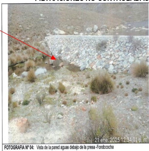
FOTOGRAFIA N° 04: Vista de la pared aguas debajo de la presa-Fondococha
