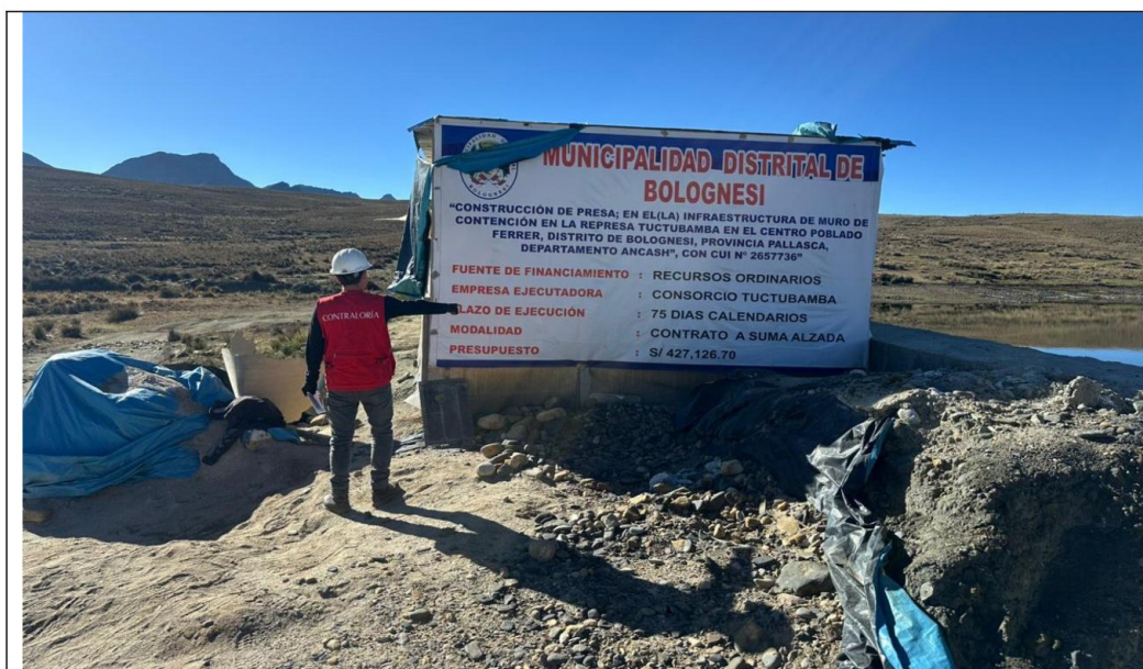
IMAGEN N° 14 CARTEL DE IDENTIFICACIÓN DE LA OBRA
